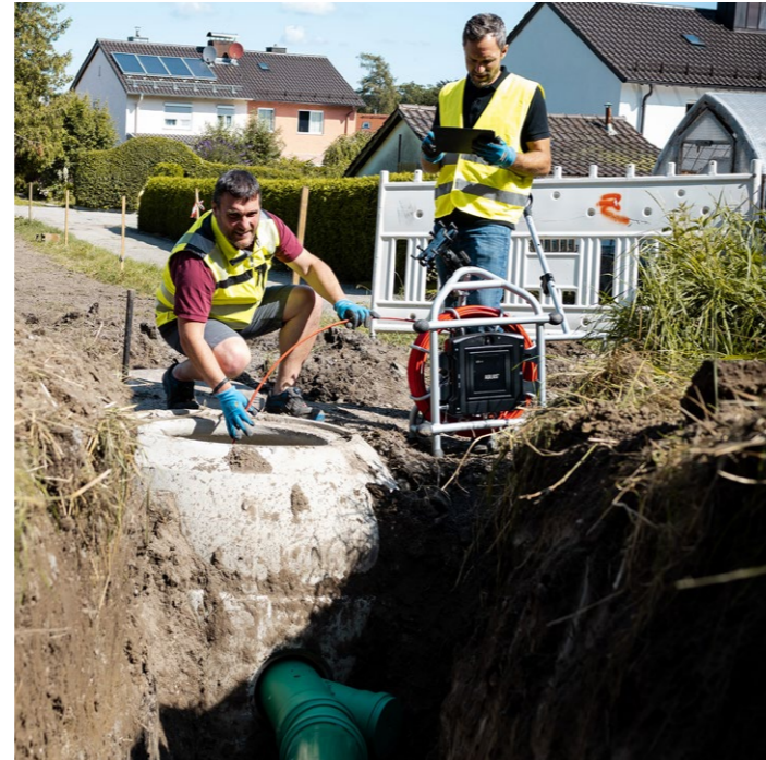
Baustelleninspektion mit Schiebekamera AGILIOS XR60
