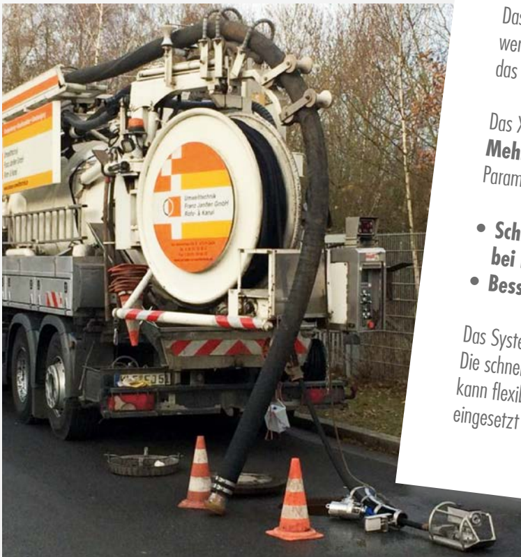
Dieses Bild entstand bei dem Reinigungseinsatz im Rohr DN 600.
